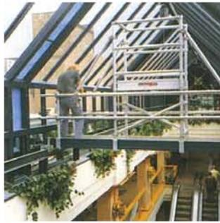
Las pasarelas se pueden montar sobre rodillos para construir pórticos de acceso móvil.
