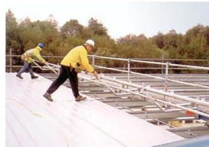
El bastidor ligero de protección del borde posterior permite maniobrabilidad sencilla y segura.
