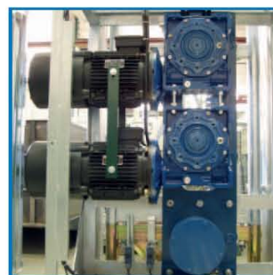
Grupo motoriz: paracaídas de seguridad independiente y motorreductores con electrofreno integrado Drive unit: independent overspeed emergency brake and gearmotors with built-in electric brake
