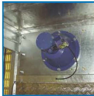
Freno paracaídas de emergencia Overspeed emergency brake
