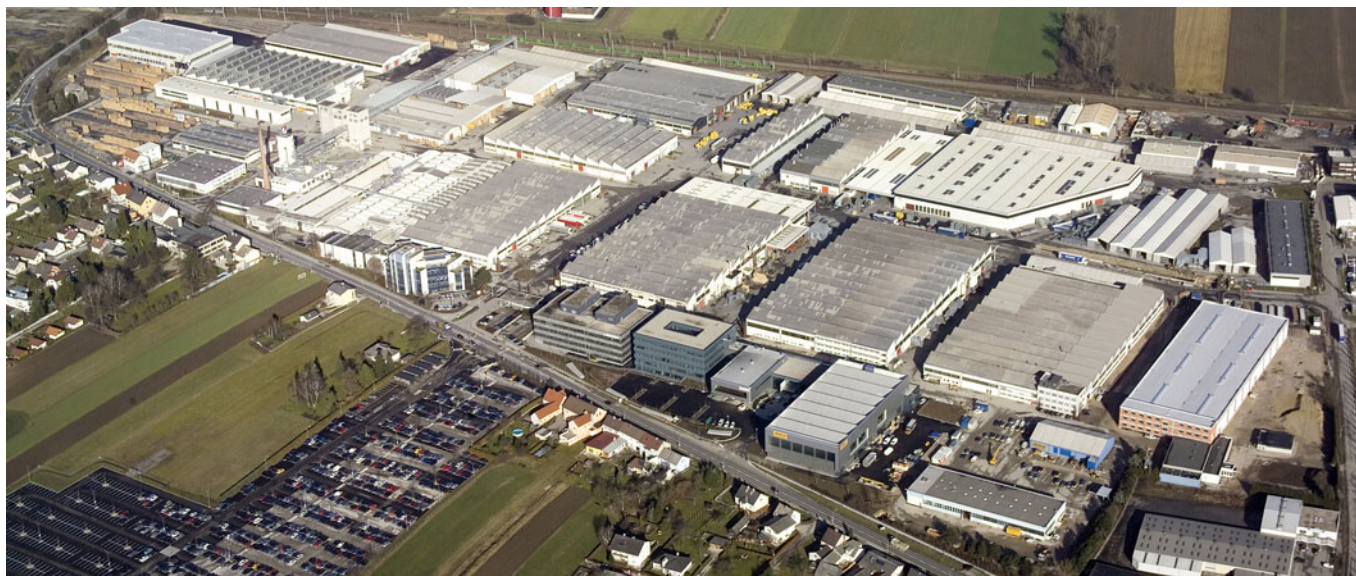
Planta central en Amstetten del grupo Doka.
