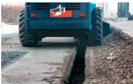
Vaciado del material del interior de la zanja en ambos lados o a un lado (opcional).
