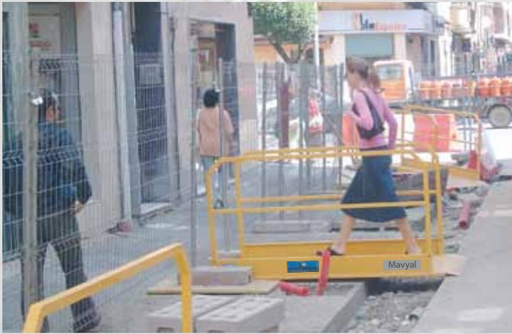
CINTERMAQ, S.L., fabrica pasarelas peatonales en chapa con capacidad de carga de 400 kg., en diversas longitudes y con una anchura útil de 870 mm.
