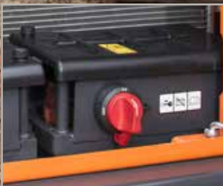
Interruptor de corte de la batería
